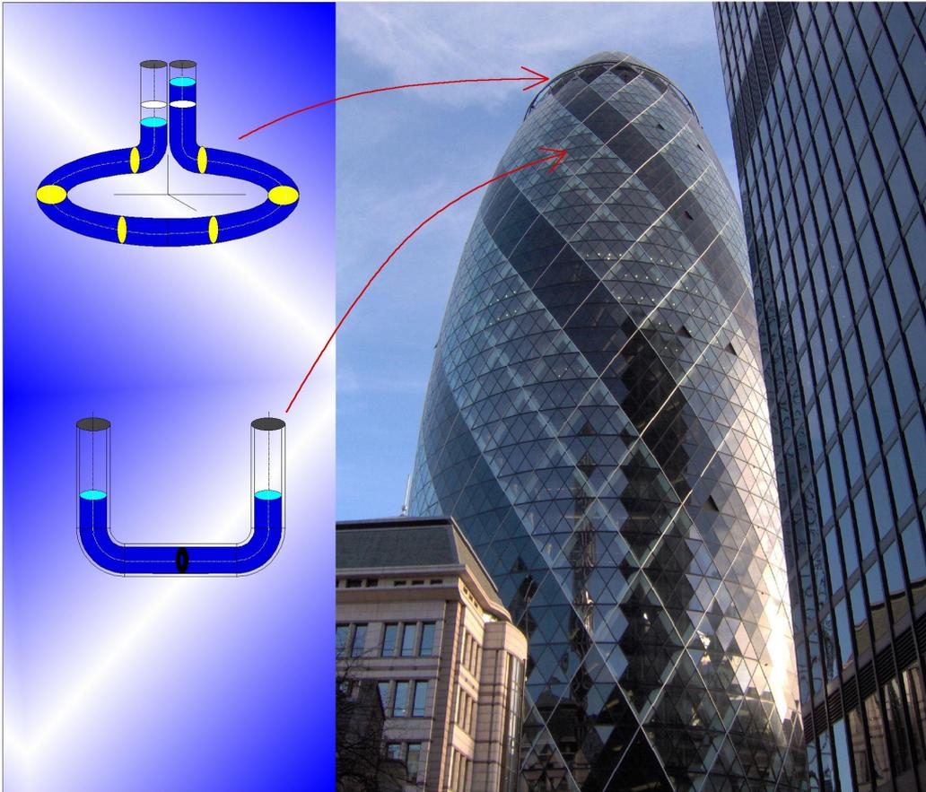
Abb. 5. Gebäudemodell mit einachsigen Tilgern und speziell angepassten (Torsions-) Flüssigkeitstilgern zur Dämpfung von Translations- und Drehschwingungen
